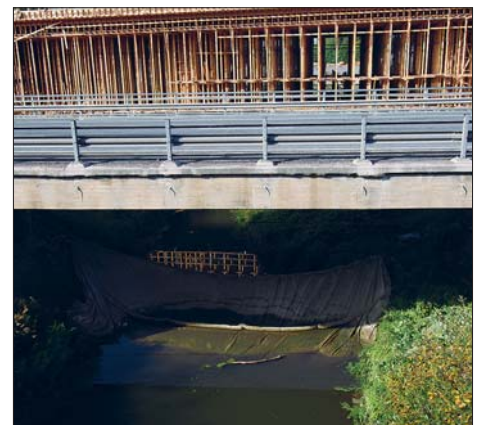
Siltatyömaa Porvoonjoen yli.
