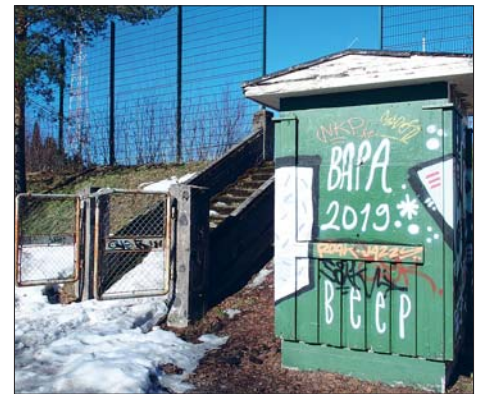
Historiallinen lippukoppi on lahoamassa ja töhritty. Portit repsottavat avoimena ruosteessa.
