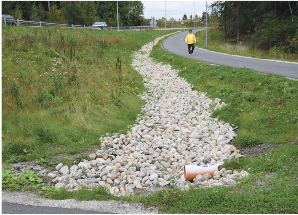
Reunakadun tunnelille laskeutuvan vedenpoisto-ojan pohja on kivetty ja hiekan peittämä poistoputken suu on avattu toimimaan. Kuva: Lasse Koskinen.
