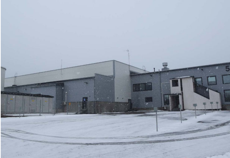
Lahden Kallio-Pietilän teollisuusalueelle rakennettu vedenpullottamotehdas on vielä aution ja hiljaisen tuntuinen kevättalvisessa räntäsateessa. Pohjavedestä Salpausselällä ei ole pulaa. Kuva: Lasse Koskinen.
