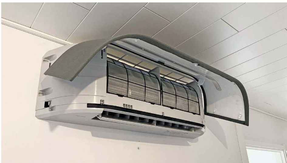
Kuva: Ilmalämpöpumpun huoneistoyksikkö.
