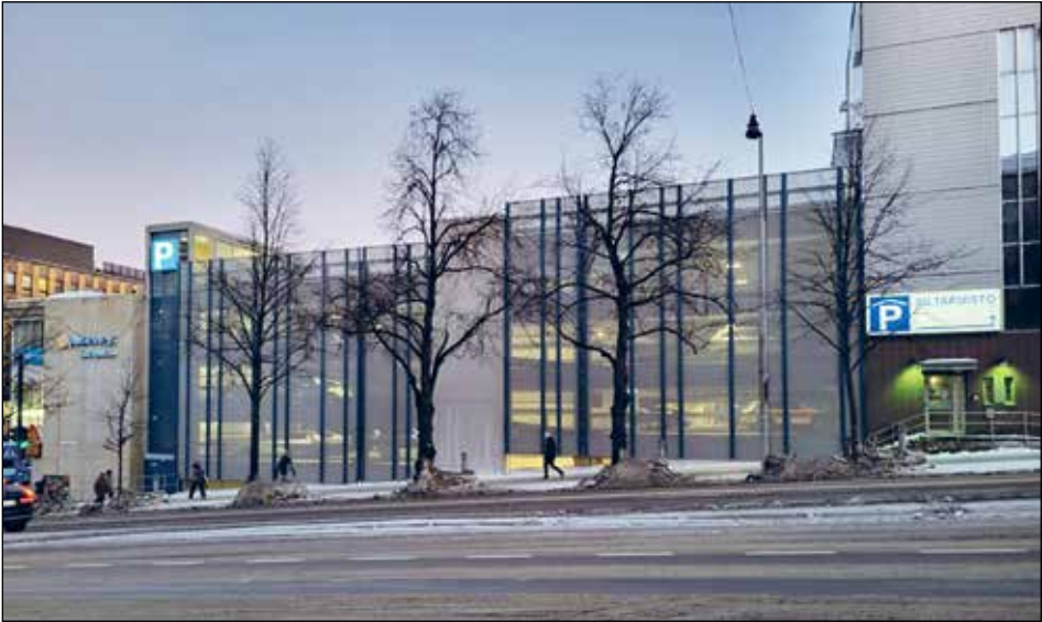
Pysäköintitalon julkisivu on uudistettu teräsrunkolla ja verkkoseinällä. Kuva: Lahden Pysäköinti Oy
