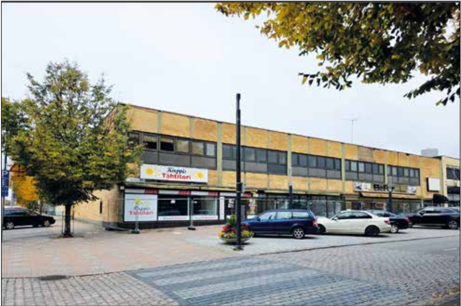
Savontie 3 kiinteistön purkaminen Heinolan keskustassa käynnistyy marraskuussa 2025. Pitkään palvellut liikekiinteistö on ollut osa Heinolan ydinkeskustan elävää katukuvaa jo yli viiden vuosikymmenen ajan.
